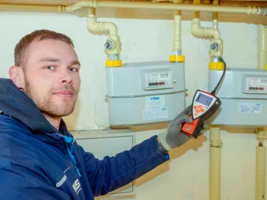
Francesco Lindig prüft mittels Sonde und elektronischem Messgerät zwei Gaszähler auf ihre Dichtheit.
