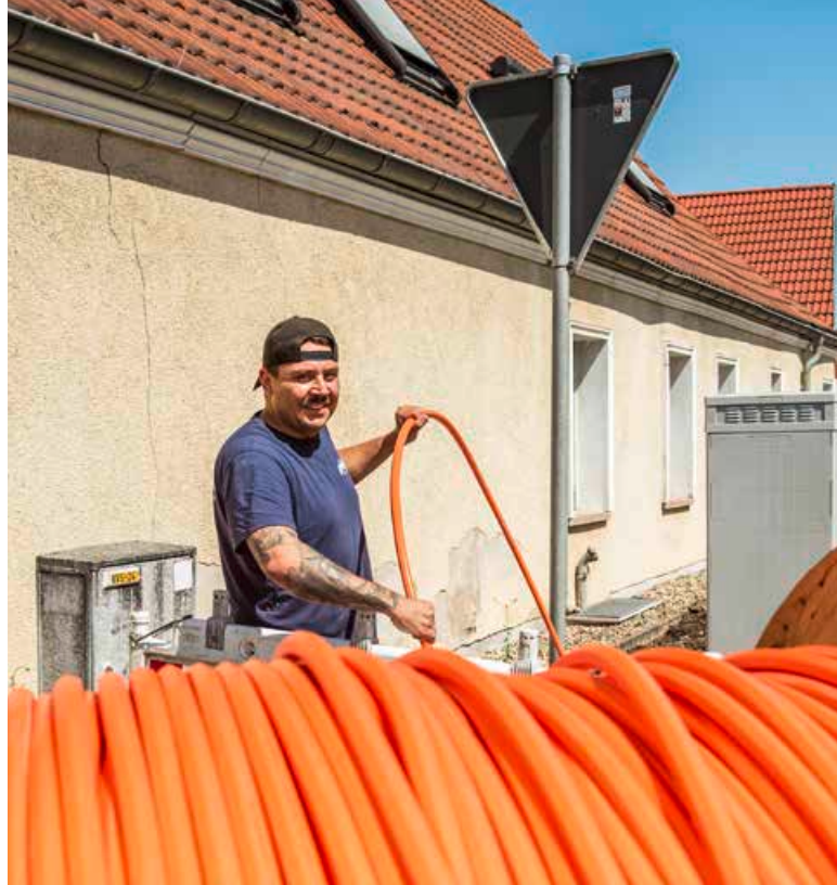
EMS-Monteur Patrick Oswald verlegt Leerrohre, in die anschließend Glasfaserkabel eingezogen werden. So sind die Kabel perfekt geschützt und lassen sich später bei Bedarf leicht austauschen.
