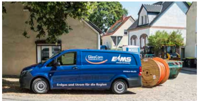
So wie hier an zentraler Stelle in Förderstedt verlegt GlasCom in weiteren Ortsteilen von Staßfurt moderne Glasfaserkabel und errichtet Hausanschlüsse.
