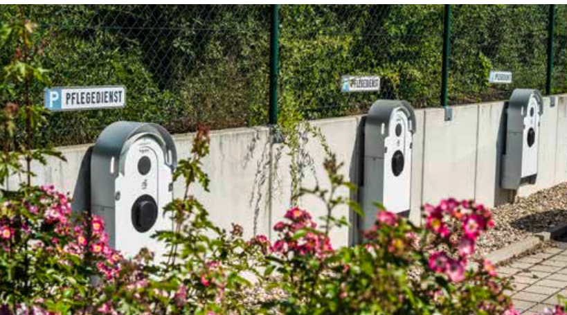
Drei von sechs Wallboxen mit jeweils elf Kilowatt Ladeleistung, die die EMS für den Pflegedienst Koschmieder installiert hat.
